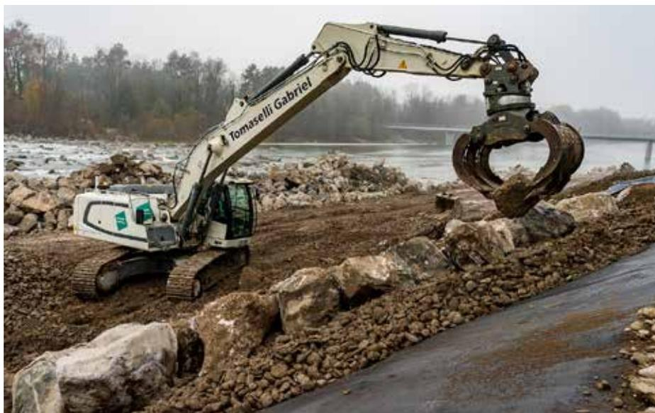
Die ersten Dammbereiche sind inzwischen saniert. Hier wurden – wo nötig – erst Bäume und Büsche entfernt, dann der Damm abgedichtet und mit Wasserbausteinen gesichert.
