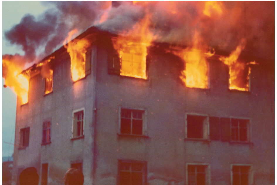
Das ehemalige Gasthaus wurde 1977 „warm“ abgebrochen.
