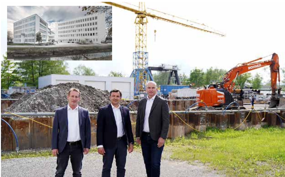
Neben dem bestehenden Verwaltungsgebäude sind die Arbeiten in vollem Gange: (v.l.) GF Georg Schuch, Bgm. Martin Staudinger, Dominik Stenech, Leiter Finanzen & Personal bei Künz
