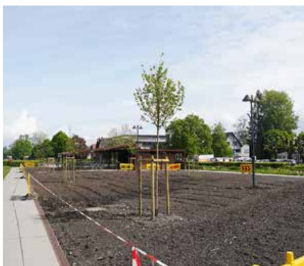
... und nach der Neugestaltung. Wo jetzt noch Erde zu sehen ist, entsteht eine Wiese.
