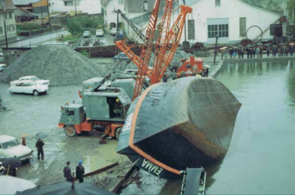
Am 16. Juli 1966 lag die „Emma“ mit dem Kiel nach oben im See. Mit Hilfe von Kränen konnte das schwere Kiesschiff wieder umgedreht werden
