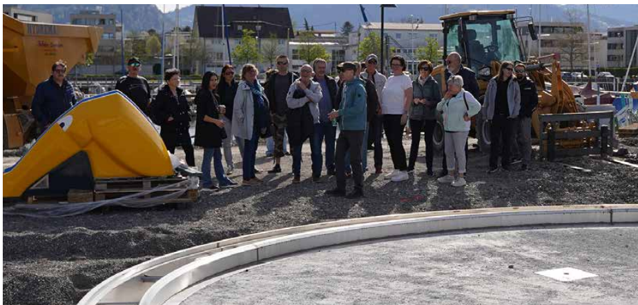
Die Möglichkeit zur Baustellenbesichtigung wurde von vielen Harderinnen und Hardern genutzt. Die Elefantenrutsche verrät es: Hier entsteht der Kinder- und Kleinkindbereich.
