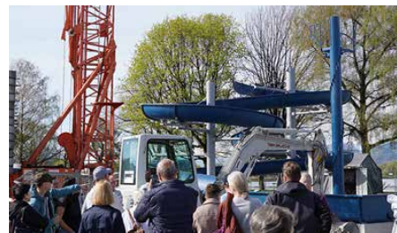
Die große Rutsche stieß bei der Baustellenbesichtigung auf großes Interesse.
