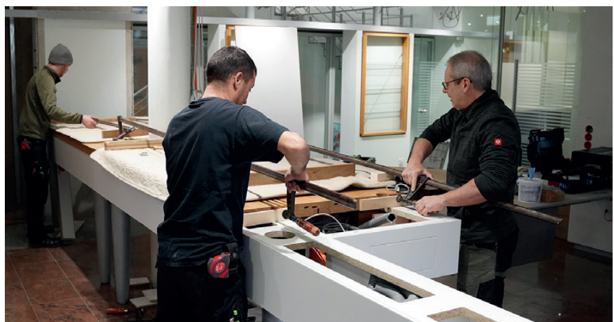
An der Bürgerservice-Stelle werden derzeit Montagearbeiten durchgeführt.
