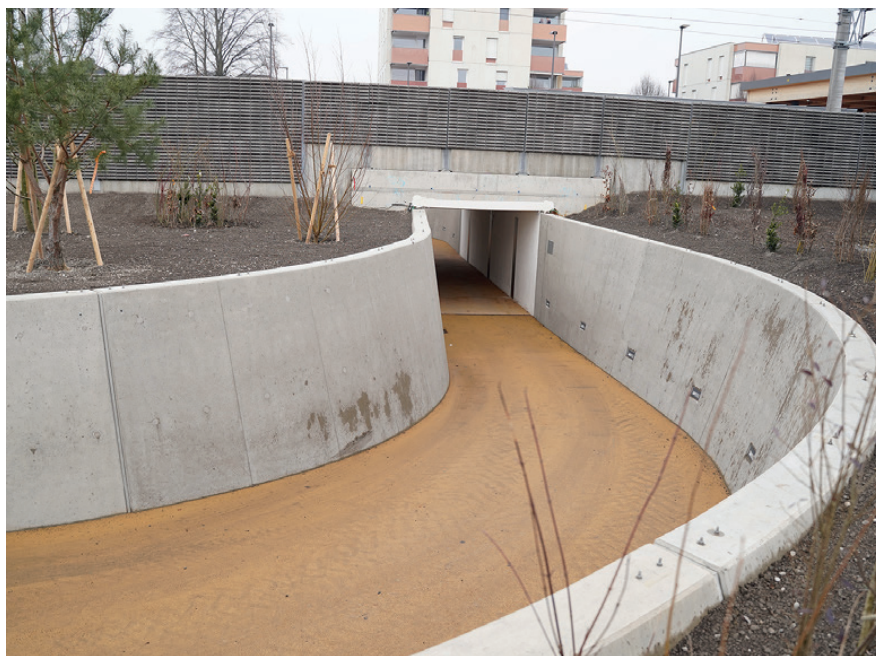
Bei Redaktionsschluss befanden sich die Arbeiten an der neuen Radunterführung auf der Zielgeraden.
