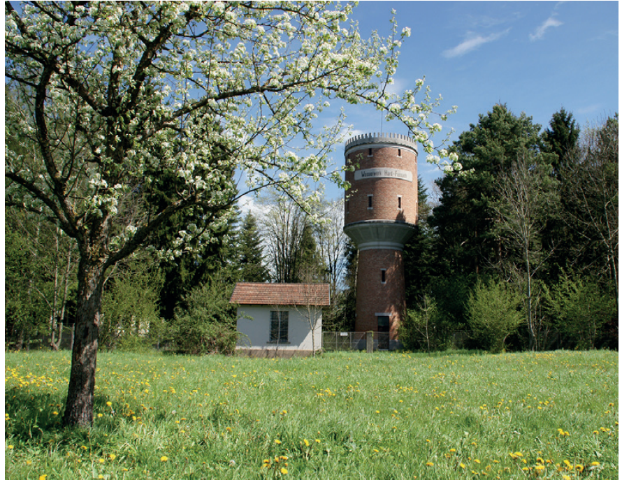
Beim Wasserturm wird ein 1.800 m 2 großer Spielplatz realisiert.
