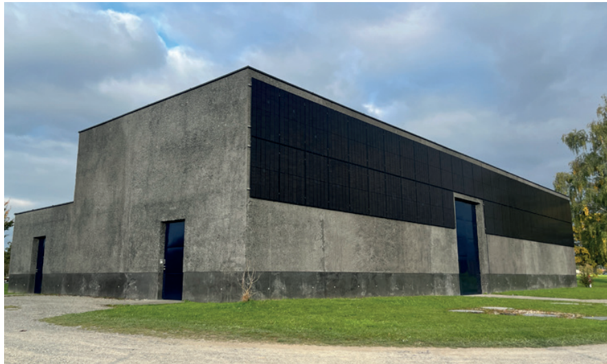
Die neue PV-Anlage an der Fassade ergänzt die bestehende Anlage auf dem Dach des Trinkwasserpumpwerks 4.
