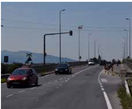
Nach rund 50 Jahren wird die Rheinbrücke durch einen Neubau ersetzt.
