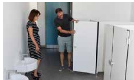
Die Sanitäranlagen für die Kinder und das Personal wurden von grundauf saniert.
