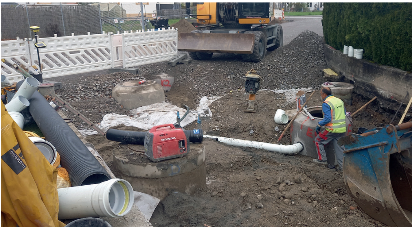
Heuer werden 2,3 Mio. Euro in das Infrastrukturnetz unserer Gemeinde investiert.
