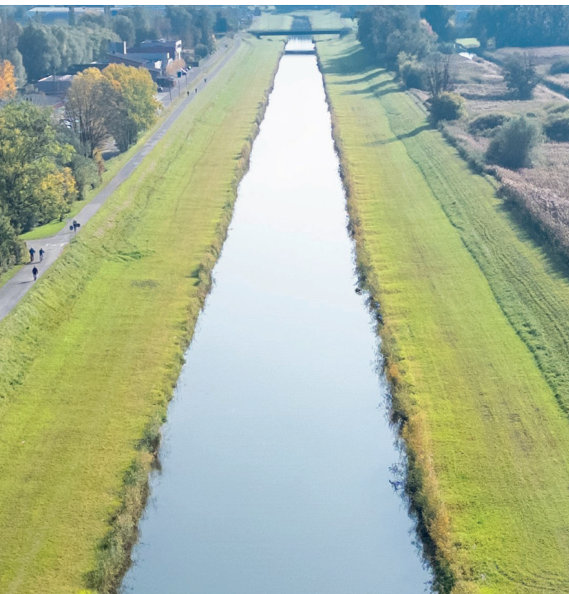
Ein Teilbereich der Dornbirner Ach vor der Renaturierung ...
